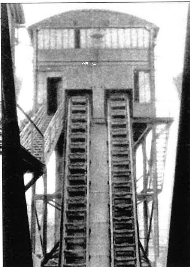
Élévation du charbon dans la tour de stockage
